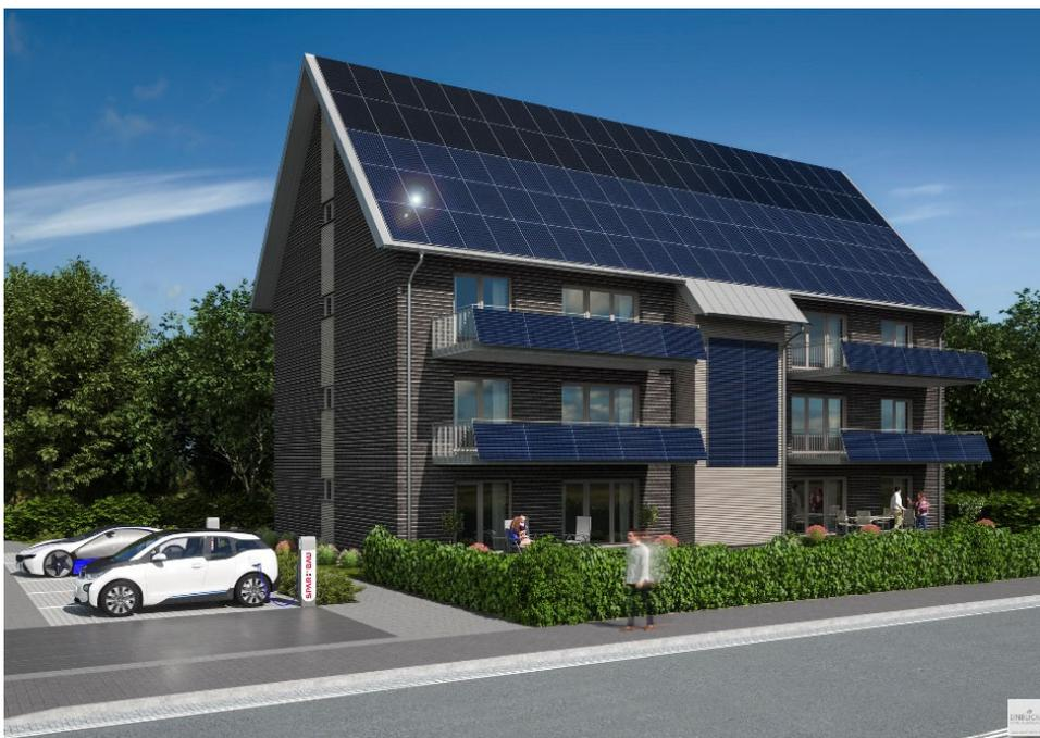
*& Abb. 12: Mieten mit Energieflat: 6 Wohneinheiten in einem energieautarken Mehrfamilienhaus in Wilhelmshaven, Fertigstellung 2018. Solartechnik auf dem Dach und an den Balkonen mit Energiespeicher erreichen etwa 70 Prozent solare Deckung des Strom- und Wärmebedarfs. Auch hier: Vermietet mit Pauschalmiete für 10 Jahre, die Wohnen, Wärme, Strom und E-Mobilität als Flatrate enthält.
