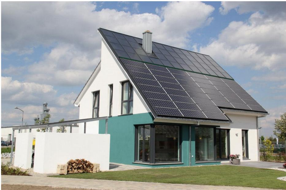
➤ **Abb. 3:** Erstes bezahlbares energieautarkes Eigenheim Europas als unbewohntes Musterhaus in Lehrte/Hannover von der HELMA Eigenheimbau AG Baujahr 2011. Es versorgt sich selbst mit Wärme, Strom und E-Mobilität: durch Solarthermie (mit Langzeitwärmespeicher), Photovoltaik (mit Akku) sowie etwas Biomasse. Primärenergiebedarf: 7 kWh/m<sup>2</sup>a.
