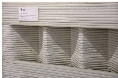
↗ Einzelne, gedruckte Schichten werden zur tragfähigen Wand.
