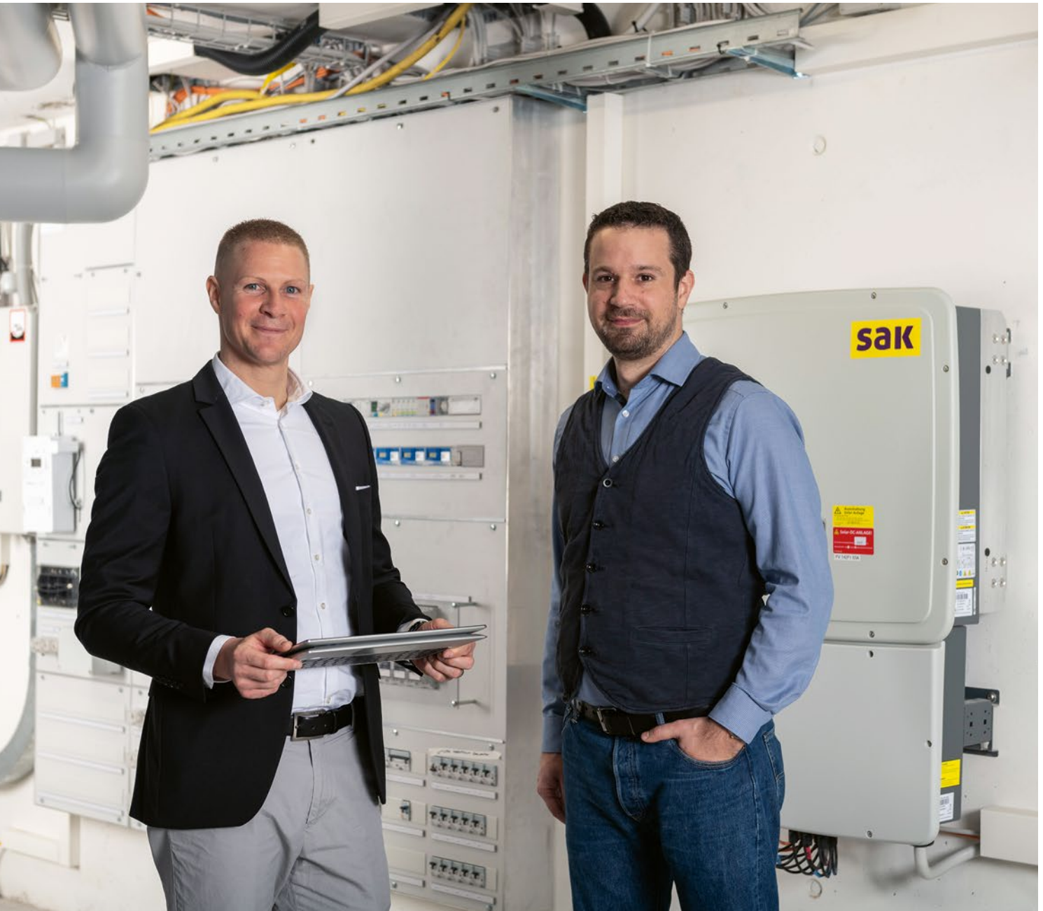
Thomas Bötschi (Strategisches Marketing SAK) und Roland Grob (Leiter Prosumer SAK) bei der Inbetriebnahme der «Multi-Energie-Lösung Schlatt-Park» im Herbst 2020.
