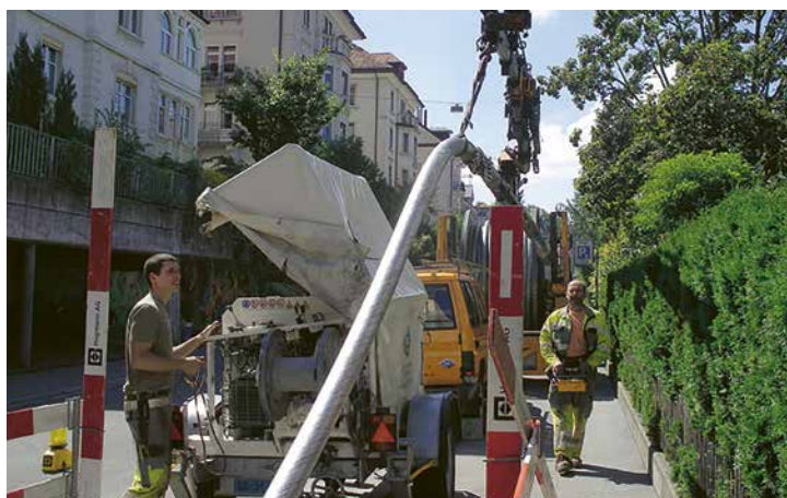
Kabelauszug mit Zugmaschine
